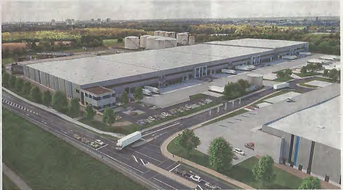
So soll das Gebiet aussehen, wenn es fertig ist, schreibt der Projektentwickler Alpha Industrial/Hagedorn. Wobei die Hallenfläche links bereits fertig und in Betrieb ist. Die Hallen rechts entstehen gerade. Weitere Hallen, die westlich der Baustelle errichtet werden sollen und auch die geplante Grünfläche sind auf dem Bild nicht zu sehen.
